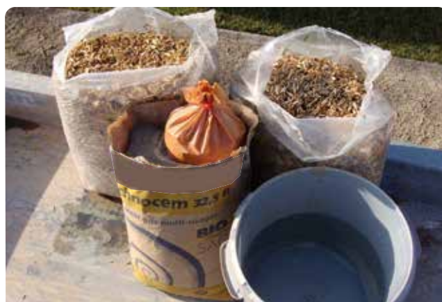
PERMEO + Colorant + Ciment + Eau
